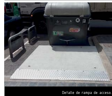
Detalle de rampa de acceso.
