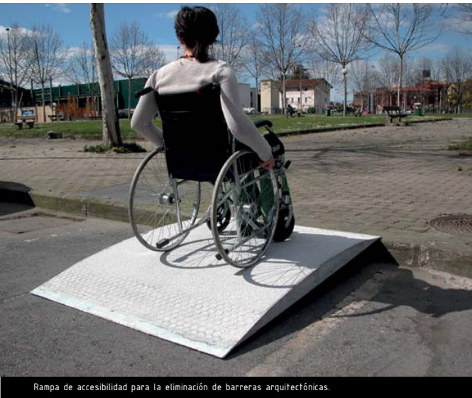
Rampa de accesibilidad para la eliminación de barreras arquitectónicas.
