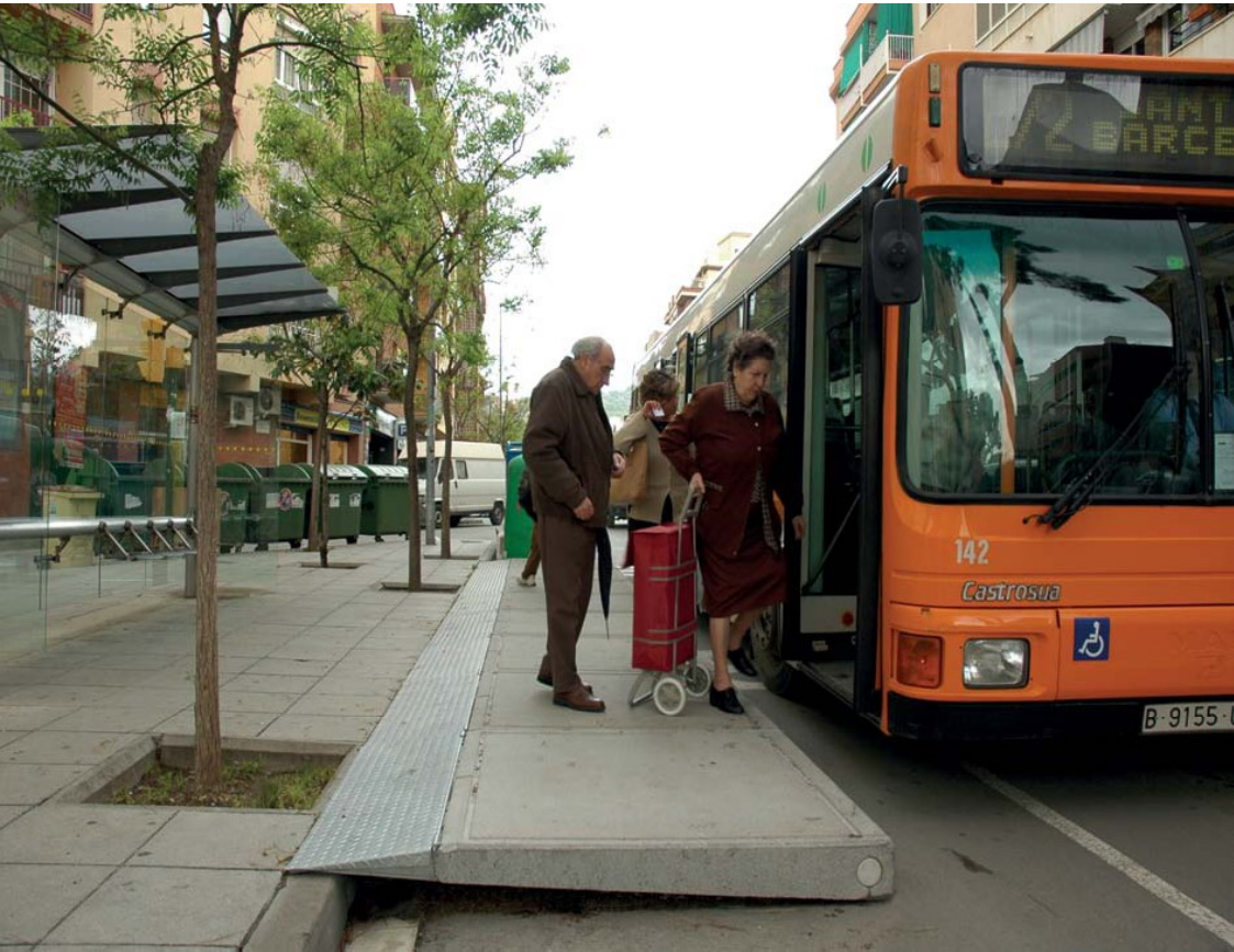
Combinación de 10m de Andén modular en puente entre acera y calzada.
